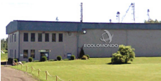
Installation Pilote d'Ecolomondo
